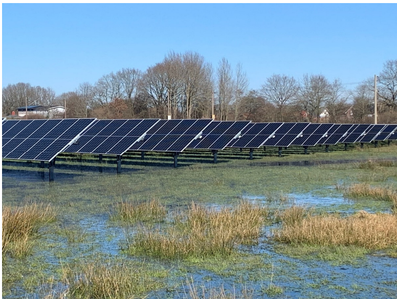
Abbildung 3-5 PV-Freiflächenanlage „Solarpark Lottorf“ der Wattmanufactur im teilweise wiedervernässten Niedermoor in Schleswig-Holstein (Foto: B. Spanjers)
