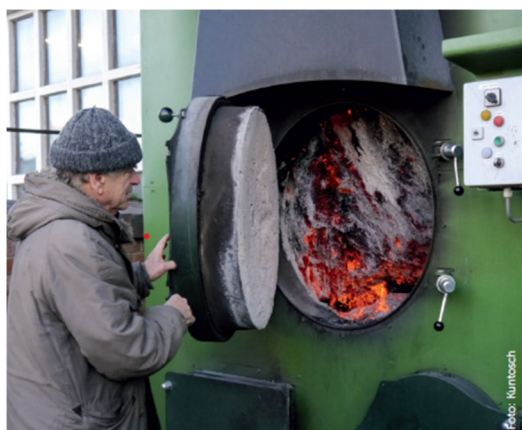
Abbildung 5-4 Wärmeproduktion durch Vergasung auf dem Hof der Göritzer Agrar GmbH (Foto: Kuntosch)
